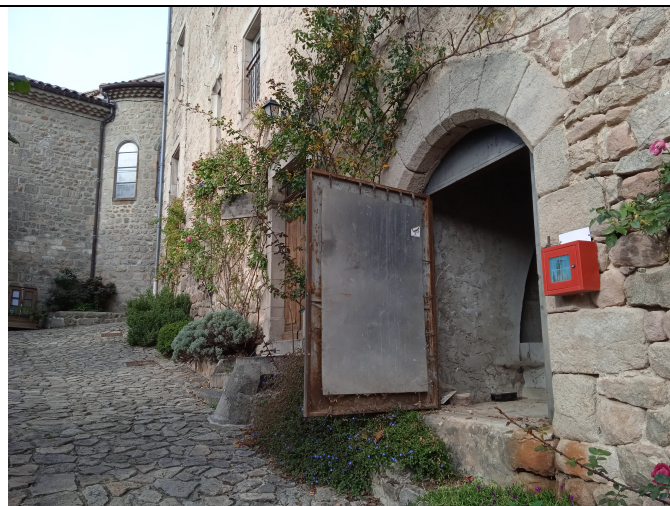
Porte accès chaufferie fioul actuelle du gîte Les Blés d'or
